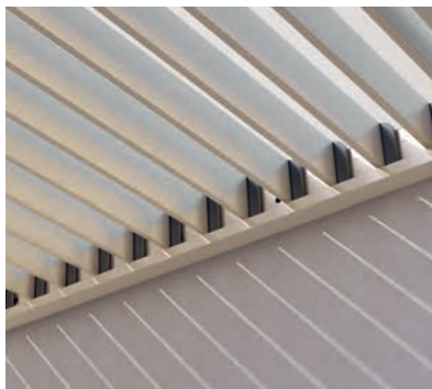
TR4520 Montering i dörrar/fönster
